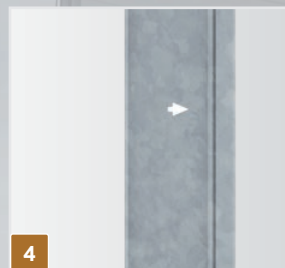
4 Markierungspfeil auf einer Höhe von 950 mm
